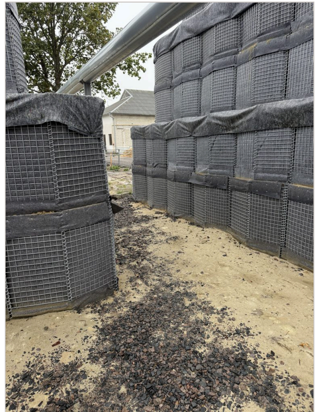
Befüllte HDGDEF-Einheiten mit Geotextil-Auskleidung
